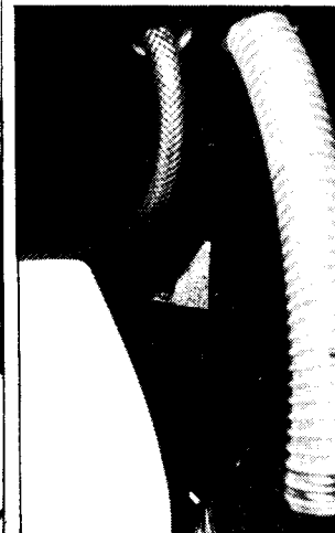
5 L'arrivée d'eau de mer directement à la cuvette
