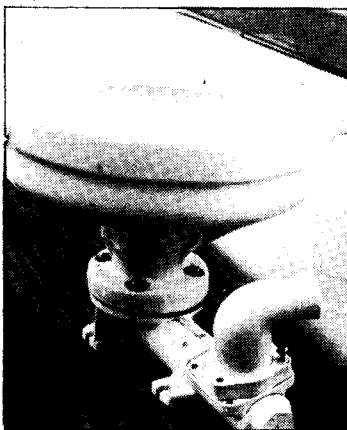
6 Les joints néoprène ▼ assurent l'étanchéité
