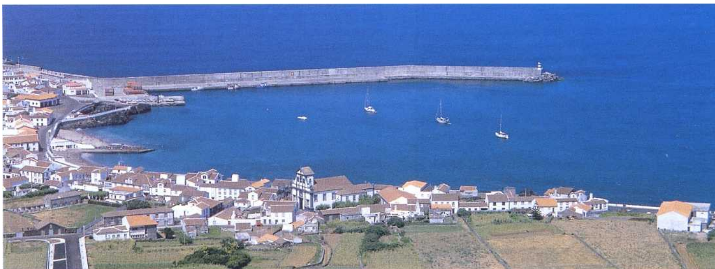
Le brise-lames et le mouillage de Vila Praia, photographiés depuis la colline de Senhora da Sauce au sud-ouest.
