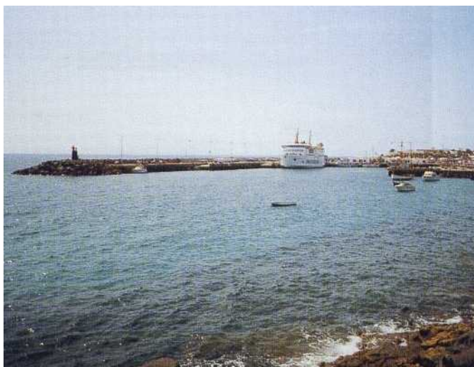
Puerto de Playa Blanca vu depuis le nord-est. Le car ferry de Fuerteventura est amarré le long de la jetée. Le chantier naval est sur la droite, avec les voiliers au-delà.
