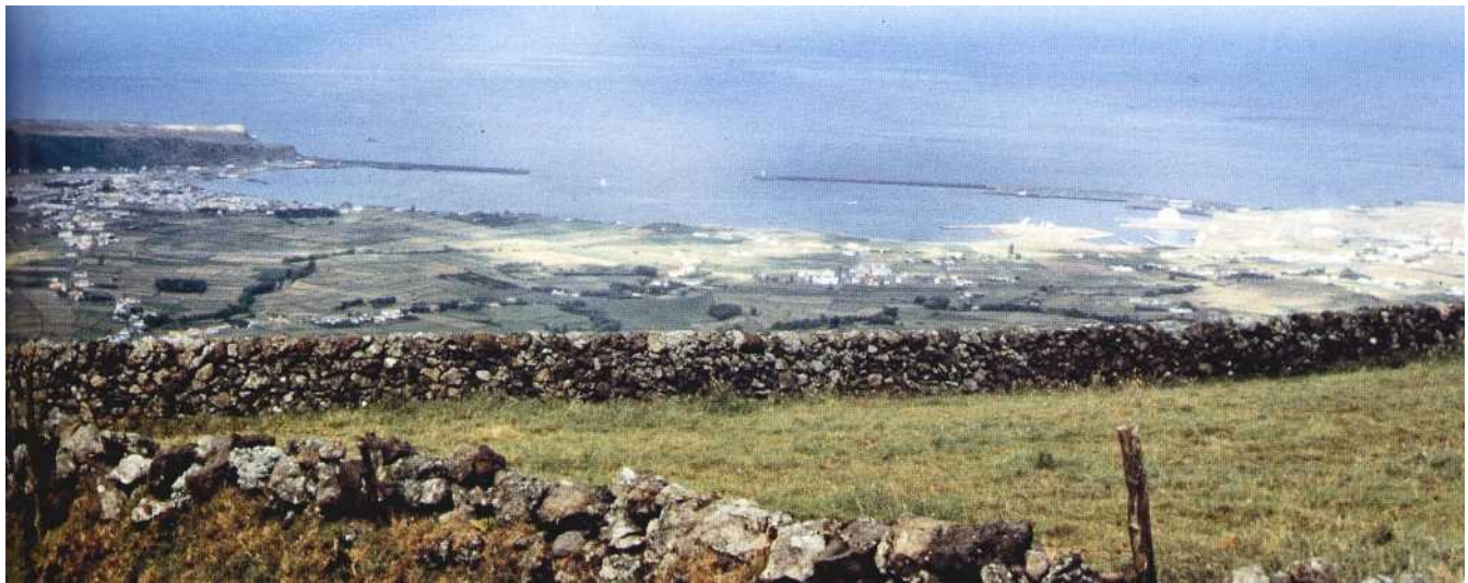
Cette vue lointaine depuis l'ouest donne une idée de la longueur des deux jetées de Praia da Vitória.
