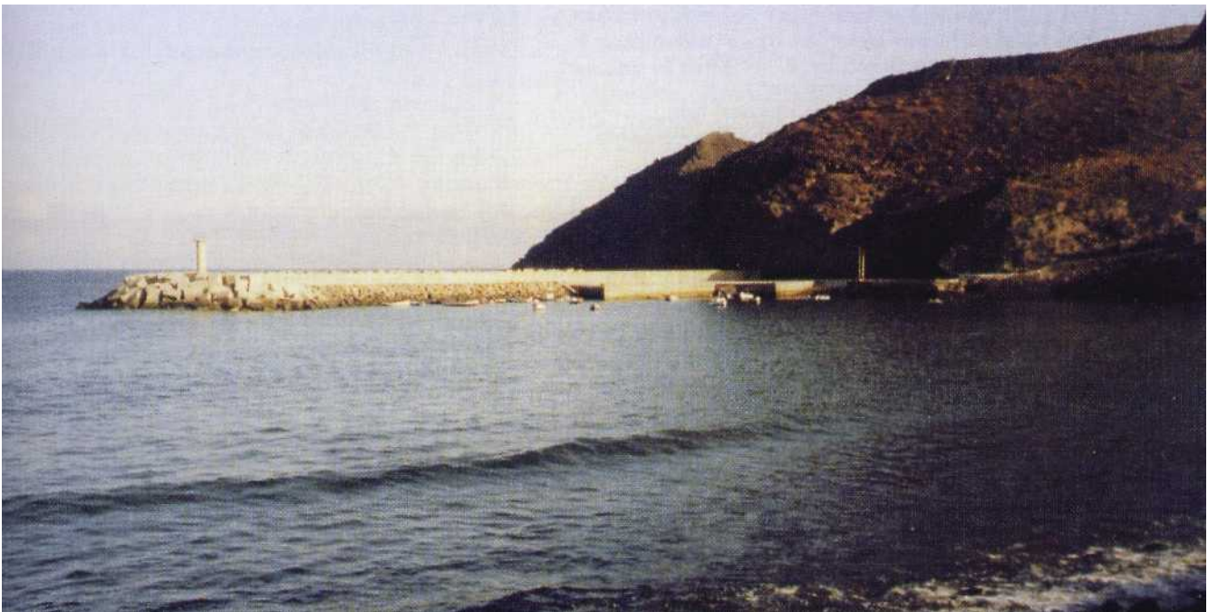
La nouvelle jetée de Puerto de la Aldea (Puerto San Nicolas) vue depuis le sud-est.
