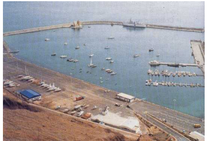
Le grand port dans la Baía de Porto Santo vu depuis les collines au nord. On voit la plupart des installations décrites dans le texte la marina derrière le môle en béton, la rangée des corps-morts en ligne, le travel-lift et trois des quatre coffres d'amarrage.
