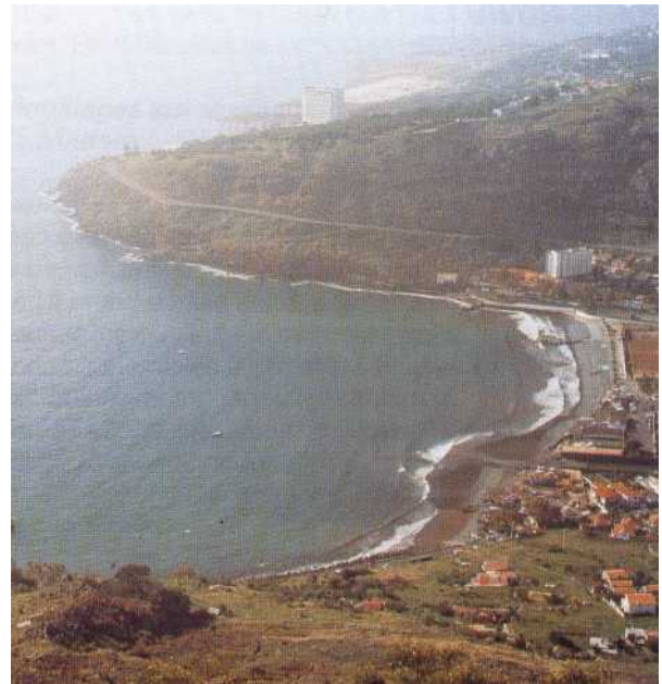
La grande baie de Machico vue depuis un point de vue au nord-est. Deux bateaux, associés à la construction de la piste d'atterrissage de l'aéroport, attendent à proximité du petit môle. Malgré la brume, on peut voir au loin le remblai en béton qui supporte l'extension de la piste.
