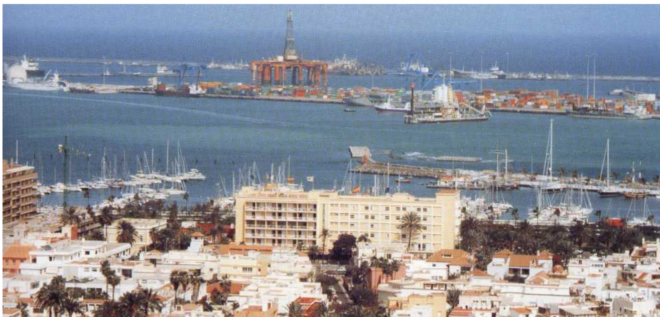
L'entrée du port de plaisance de Puerto de la Luz en mars 1998. Un môle a été construit plus tard dans l'année et sérieusement endommagé par les tempêtes du Nouvel An 1999 alors qu'il était presque achevé.
