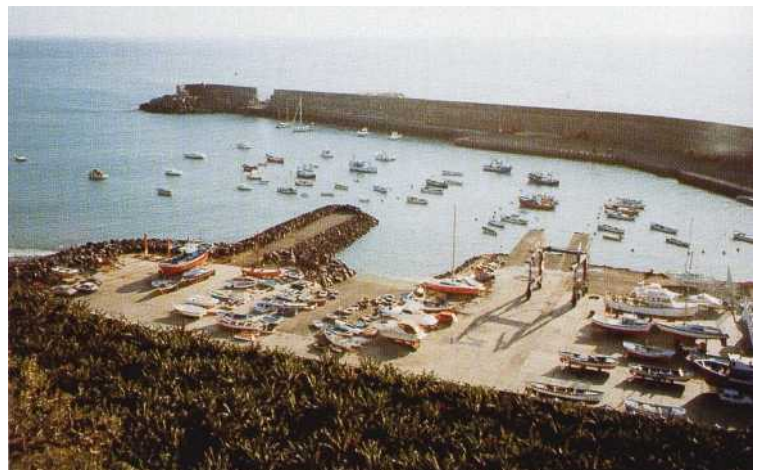
Des travaux étaient en cours sur le brise-lames de Puerto de Tazacorte en mars 1998. L'avancée partant à angle droit du brise-lames se devine au-delà du mur massif. La balise bâbord est juste au-dessus du bateau le plus à gauche.
