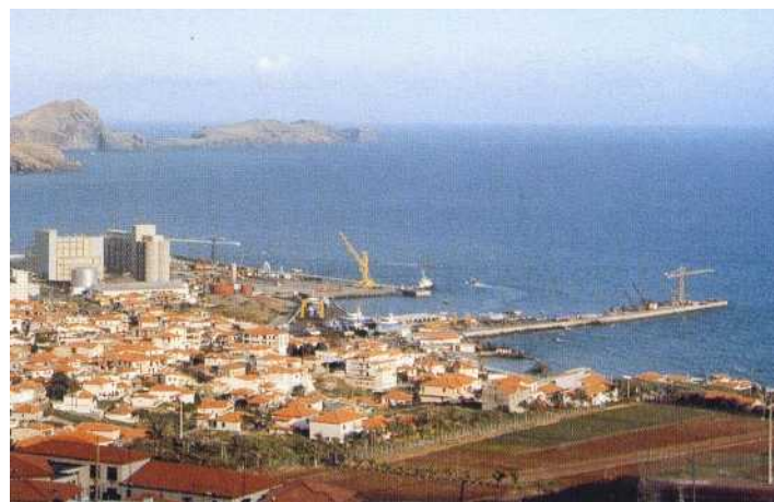
En regardant vers le sud-est, le port de Caniçal, dans la zone franche de Madère, qui n'était toujours pas achevé en novembre 1998. Les silos de béton sont très repérables du large.
