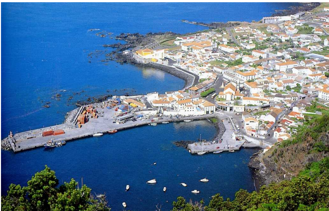
La ville et le brise-lames de Vila das Velas vus du nord-est. Les rochers derrière le port affluent clairement.
