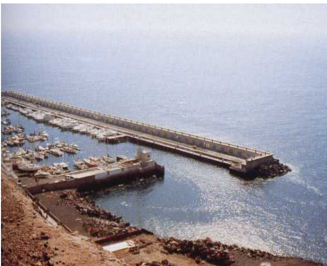
Puerto Radazul depuis le nord-ouest. Les bateaux de passage se mettent normalement contre le quai vide que l'on voit derrière le bureau de la marina, situé sur le môle nord.
