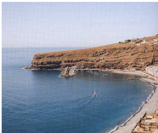
La petite baie de Santiago de la Gomera vue depuis la pointe au nord-est. Depuis la prise de cette photo, la jetée a été sérieusement endommagée par les tempêtes et la houle.
