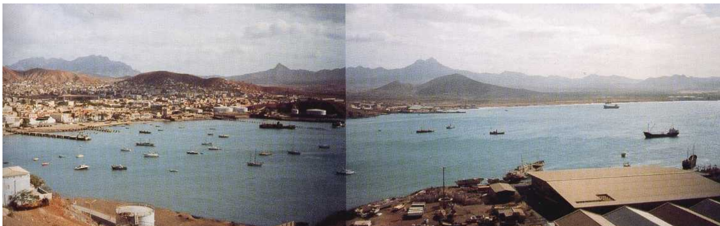
Le mouillage de Porto Grande, en face de Mindelo et avant la construction du nouveau quai.
