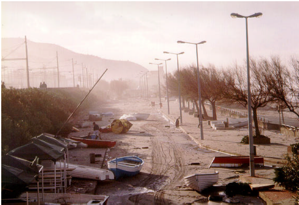
Fig. 3.3: Danni provocati dalla mareggiata lungo il litorale in Calabria.
