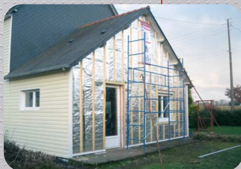
Isolation sous bardage
