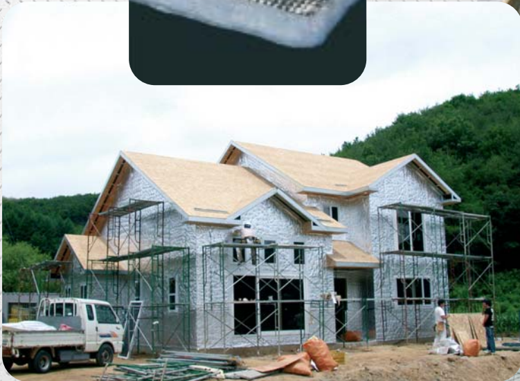
Isolation Thermique par l'Extérieur (ITE)
