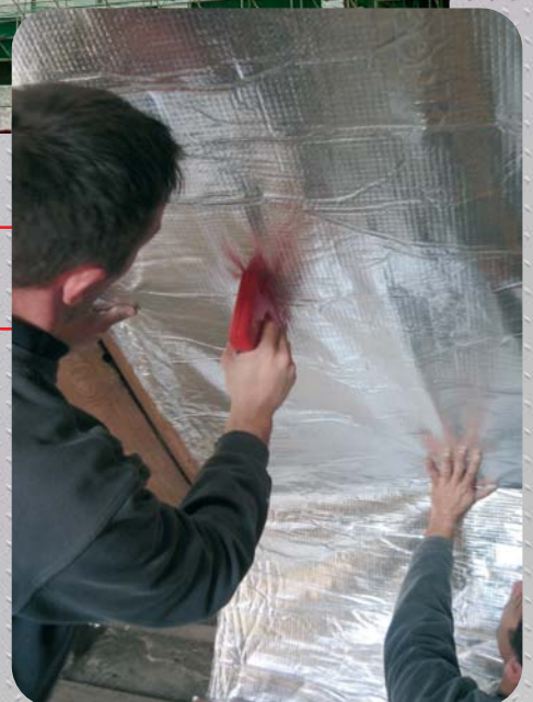
Facilité de pose
