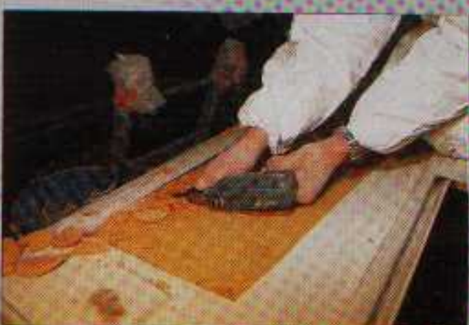
Pour dégager la mousse sous les rebords, rien de mieux qu'une meche de perceuse.
