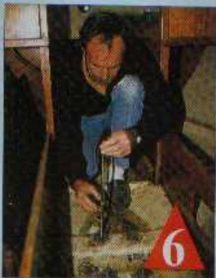
6 Un écrou remis en place sur chaque tige filetée permettra de faire descendre progressivement la quille, une fois celle-ci décollée du fond de la coque.
