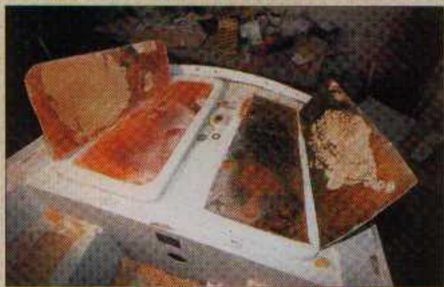
Encore une étape où l'on cassera ! Cette fois, il s'agira de l'ouverture du pont totalement délaminé. Ambitieux.
