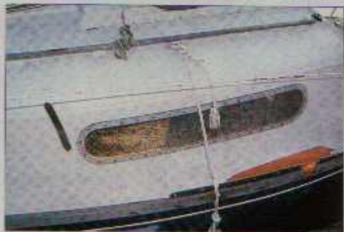
Le plexi des hublots est « étoilé », ce qui influe plus sur l'esthétique que sur la solidité.
