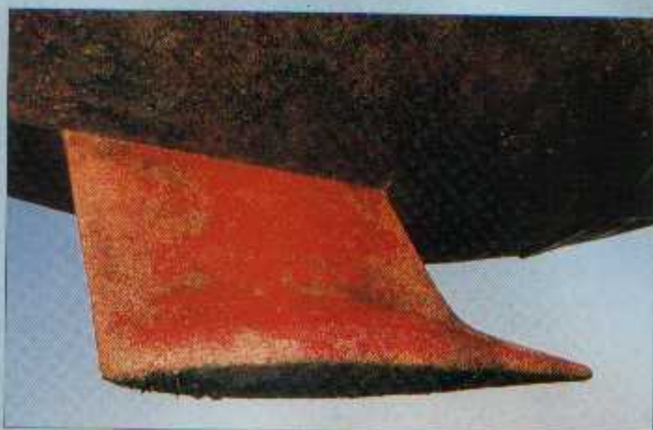
Extérieurement, et avant sa dépose, la quille en fonte d'un poids de 400 kg semblait en bon état.
