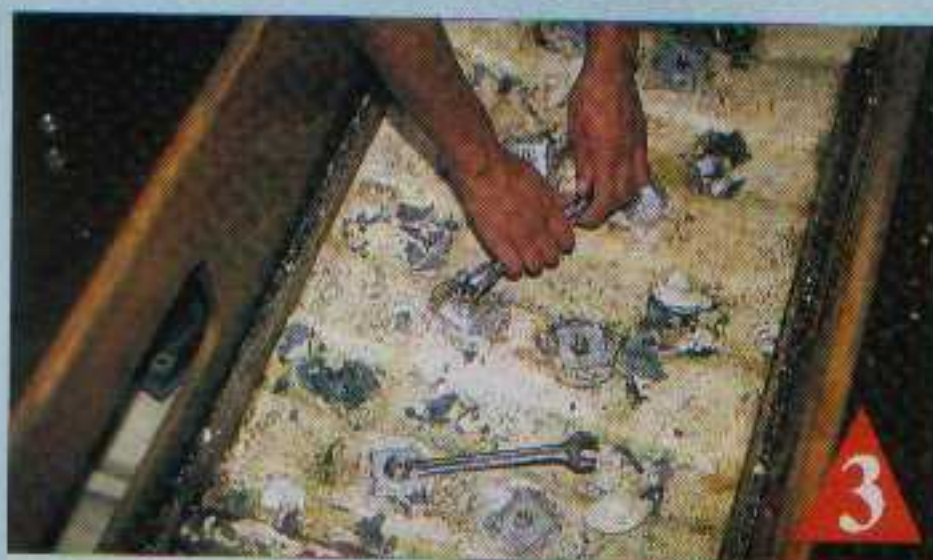
3 Une fois les écrous dégagés de leur « pâte » de protection, une simple clé de 17 s'avéra suffisante pour les desserrer.
