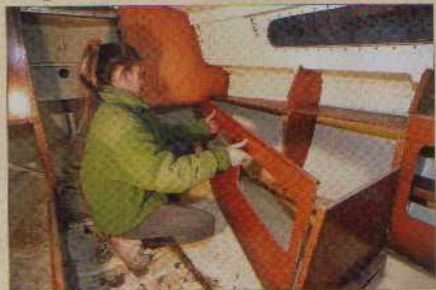
L'hiver est là ! Aussi avons-nous rentré le Sylphe dans le hangar du Chantier naval des Minimes pour être au chaud afin d'attaquer le démontage des aménagements.
