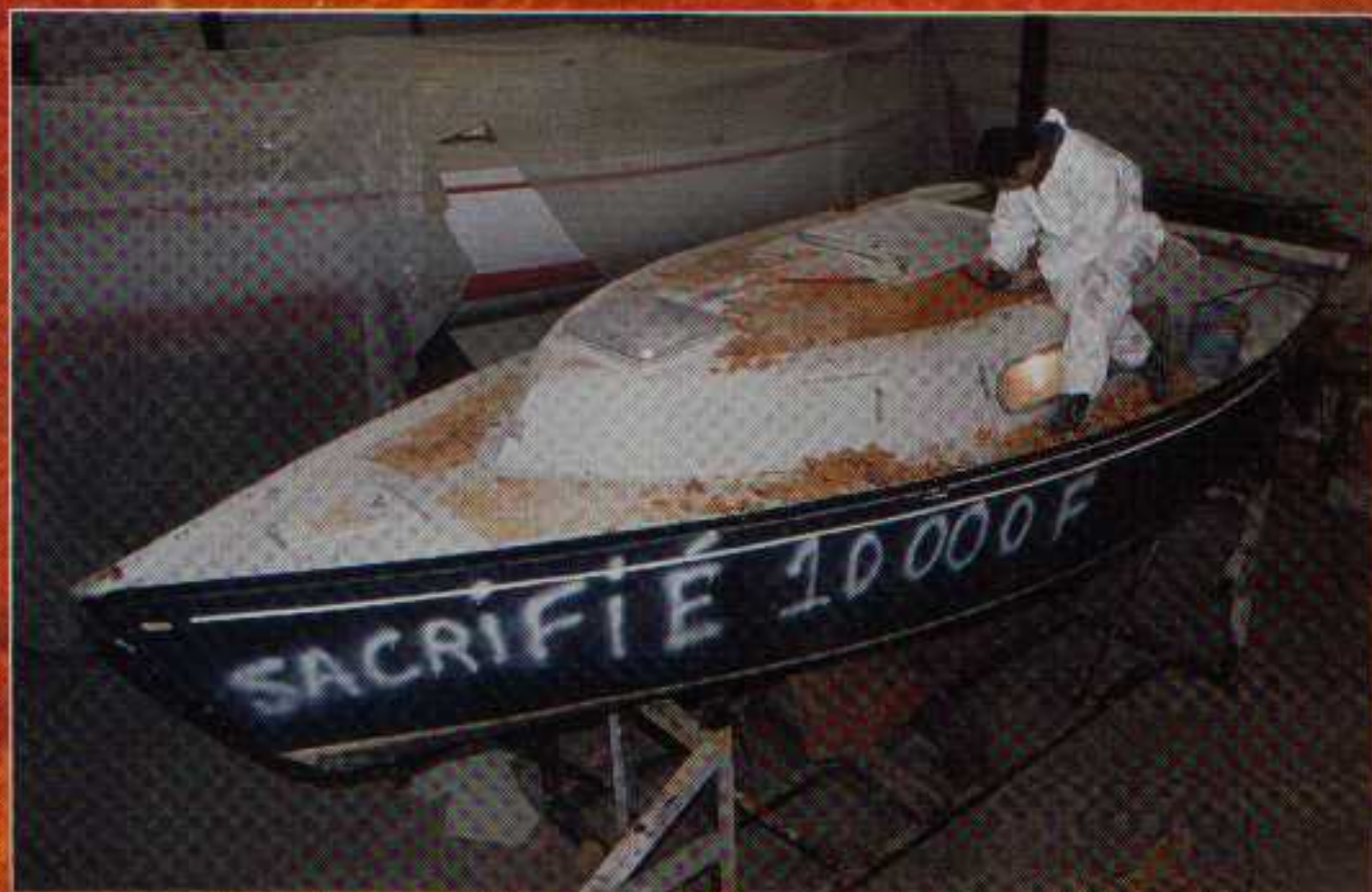
Le pont est soigneusement ouvert sur les parties qui intègrent de la mousse polyuréthane.
