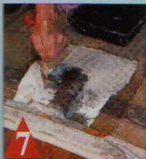
7 ... afin d'appliquer un tissu en fibre de verre bibiais.
