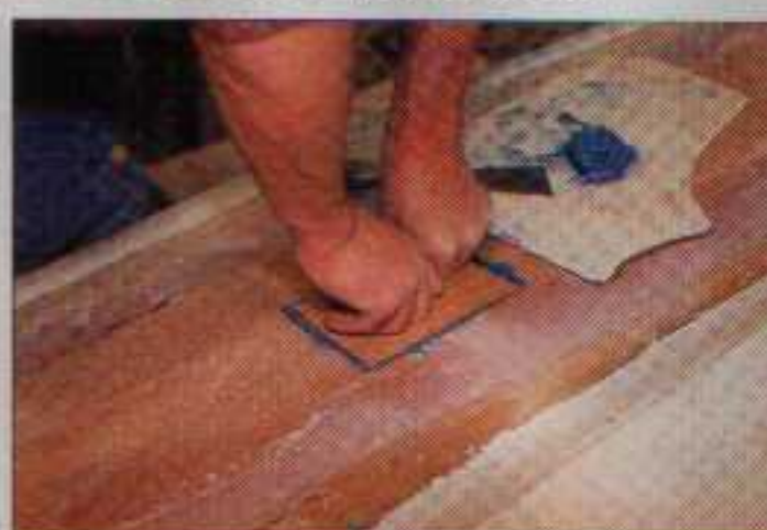
Ce trou est « choucrouté » et la pièce en teck emboîtée jusqu'à faire dégueuler la colle.
