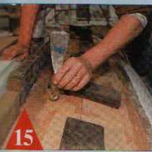
Tapoter ainsi permet d'assurer (au bruit) un collage régulier.
