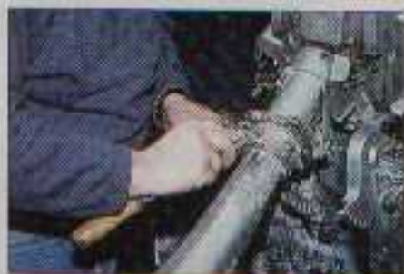
La rouille est grattée et la peinture poncée.
