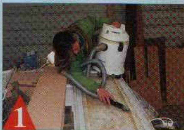
1 Après le grattage de l'ancienne mousse, un sérieux nettoyage à l'aspirateur s'imposait.
