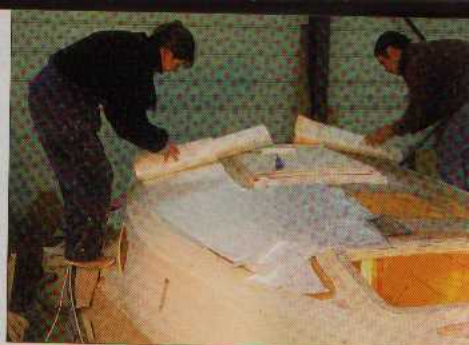
Les quatre épaisseurs de tissu (2 mats et 2 rovings) de verre sont coupés aux cotes exactes des zones à stratifier.
