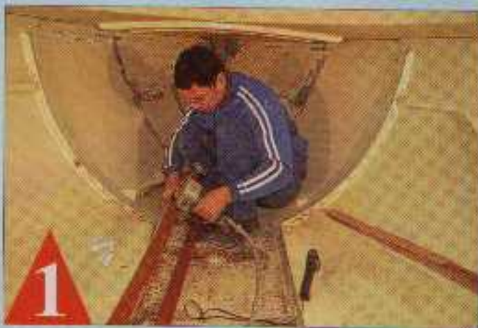
1 Pour réaliser rapidement un gabarit à la forme de la baille, prenez des lattes de bois...
