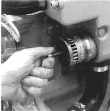
Herausnehmen des Wärmetauschers Dépose du faisceau de l'échangeur de chaleur
