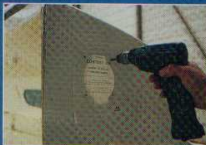
Le gabarit de montage autocollant facilite bien le perçage et le découpage de la cloison.
