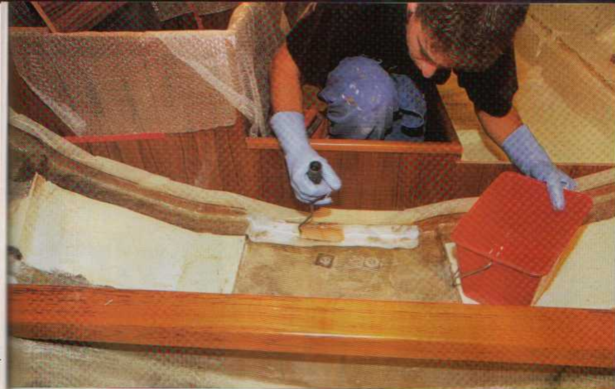
Ci-dessus, la stratification à la coque sur la face avant de la cloison des couchettes latérales. Une opération qui rendra l'ensemble solidaire de la coque, et qui rigidifiera en plus la structure générale du fond du bateau.
