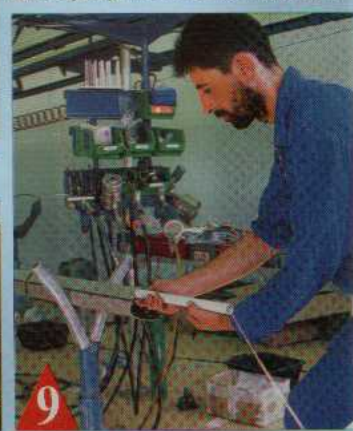
9 La phase de l'habillage du mât commence par la mise en place du câblage électrique.
