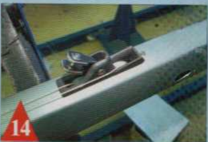
14 La boîte à réas au niveau du capelage de l'étai est fixée avec les messagers en place.
