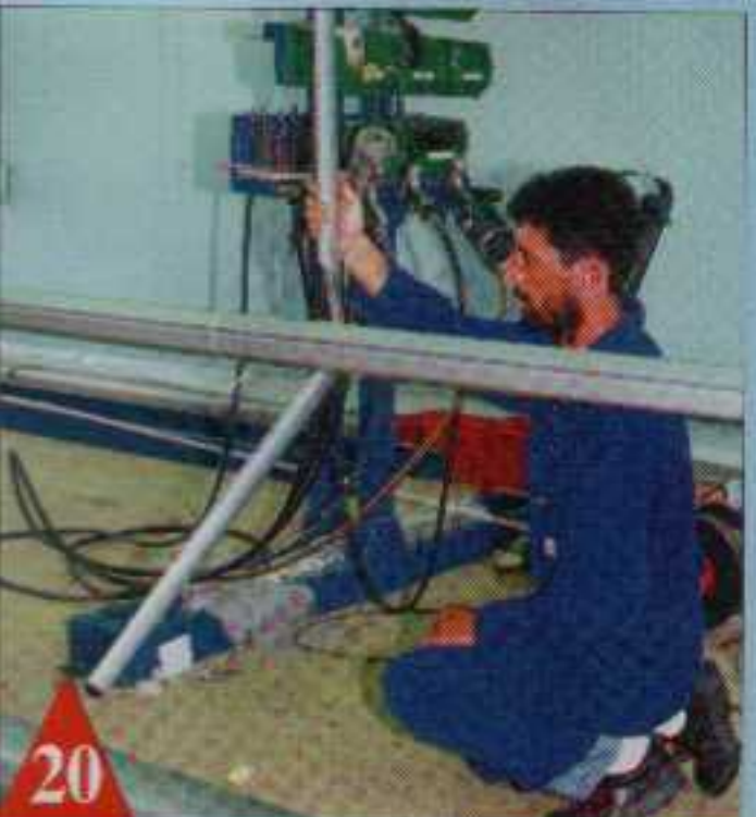
20 Les barres de flèche sont enfin ajustées puis percées pour le passage des axes goupillés.
