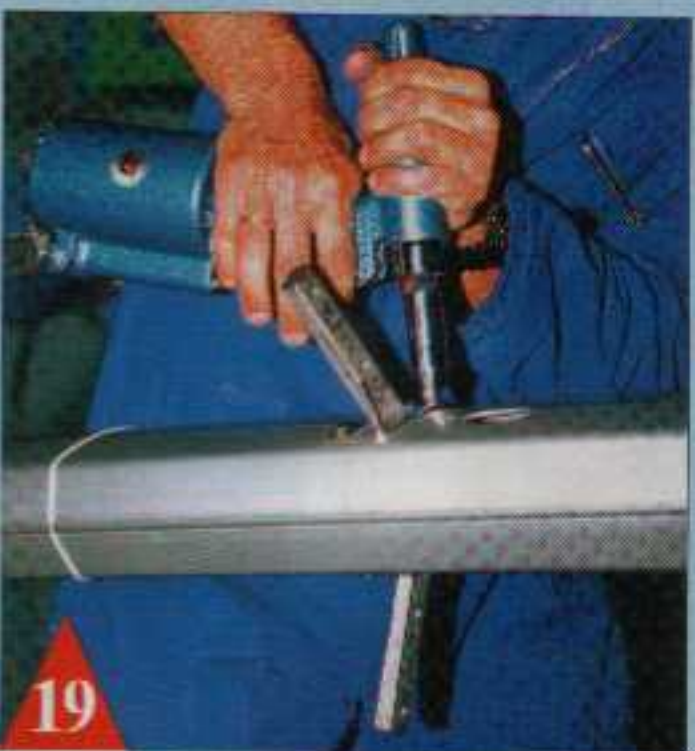
19 Cette barre en acier est alors positionnée et maintenue par des plaques inox rivetées.
