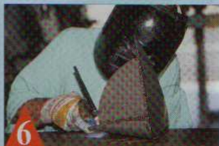
6 Les premiers points de soudure sont complétés par d'autres plus rapprochés...
