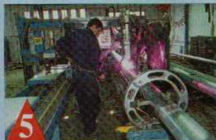
5 Le perçage du mât est effectué avec une machine à découpe plasma (à droite) commandée par une lecture optique (à gauche).
