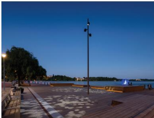
Mât aiguille avec projecteurs RGBW en grappe et projection d'image
