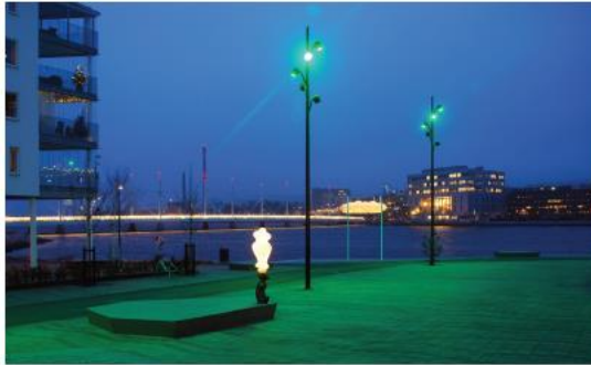
Mât aiguille avec projecteurs RGBW en grappe
