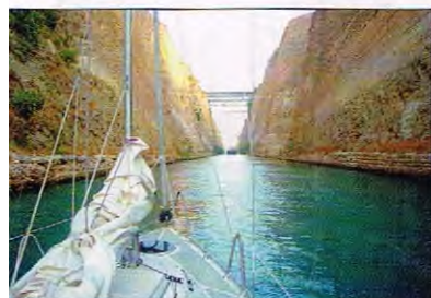
► Canal de Corinthe, Grèce.
