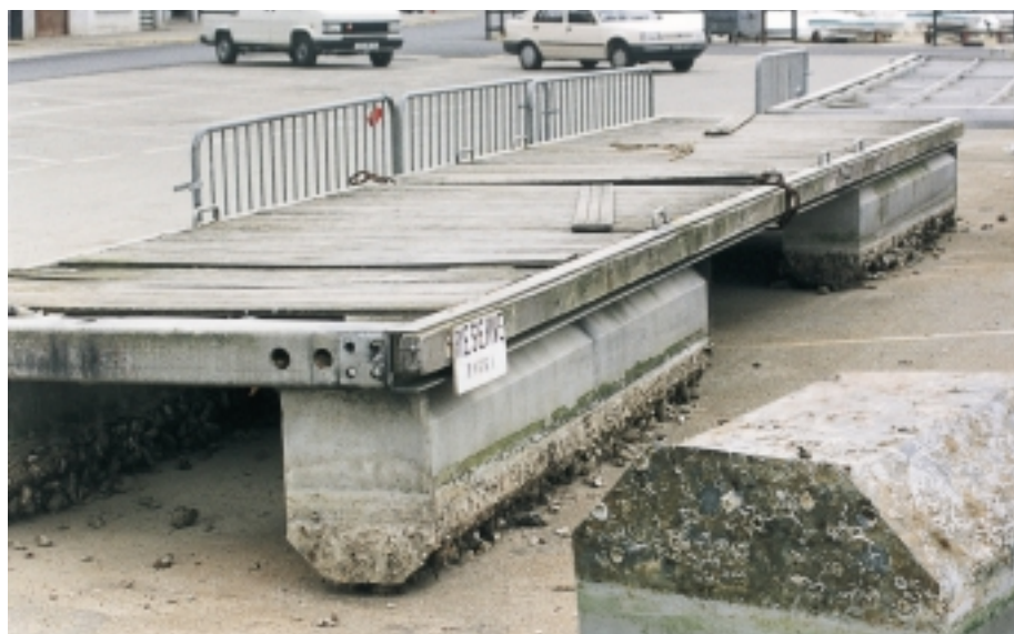
PONTON D'UN PORT DE PLAISANCE ET SES FLOTTEURS EN 5754
