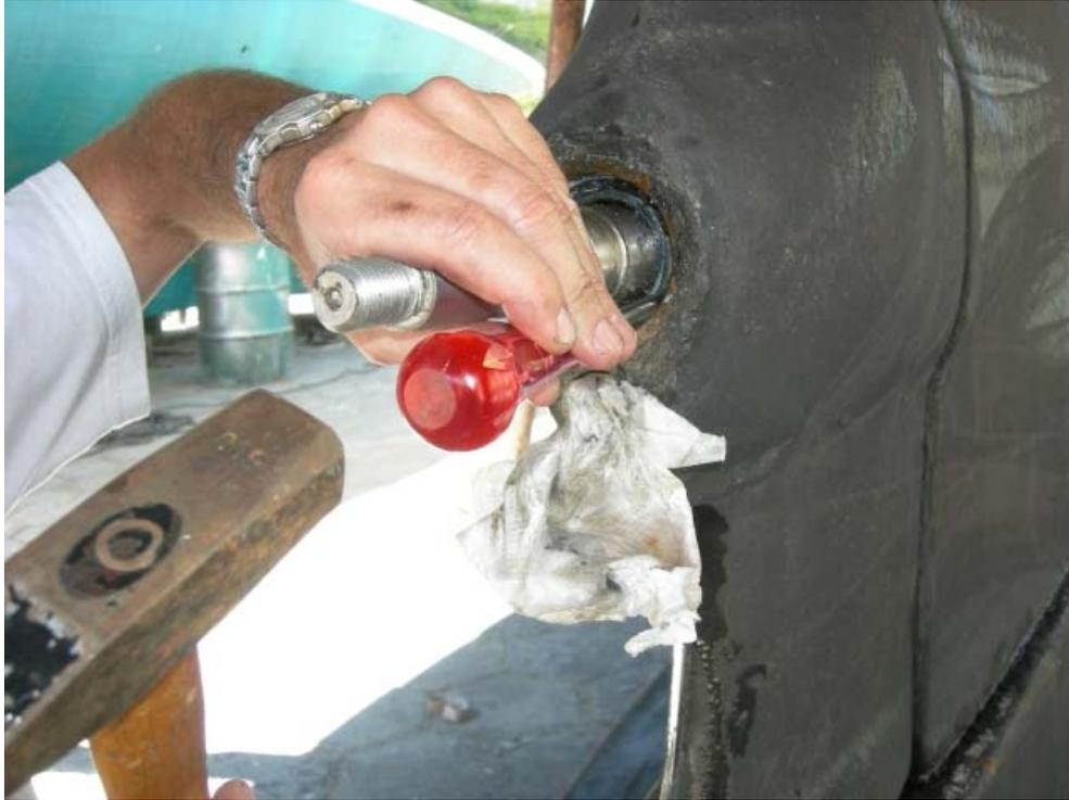
Au moyen d'un poinçon effilé, percer 2 trous diamétralement opposé sur le plat du joint et percer le métal sous le plastique. Opérer bien parallèle à l'arbre pour ne pas le blesser.
