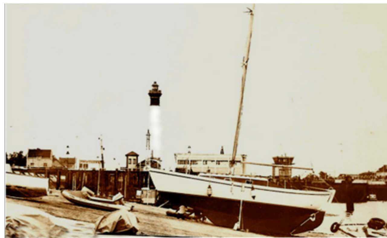
Carénage à Ouistreham avant appareillage définitif.
