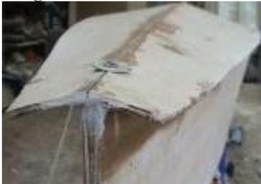
Le joint-coque vue de dessous. Le CP dépasse un peu de la coque. Une fois qu'il est bien durci, raboter et arrondir l'angle. Pour un pont vernis, créer un petit plat pour y coller un **jonc d'acajou**, façon liston. Le pont avant recouvre un peu le pont de l'arrière : un congé dans le coin suffit.
