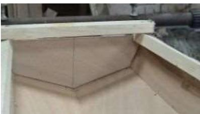
ajustement doit être symétrique. Gonfler l'étrave en écartant un peu les panneaux du fond vers l'étrave avec quelques bouts de bois.
