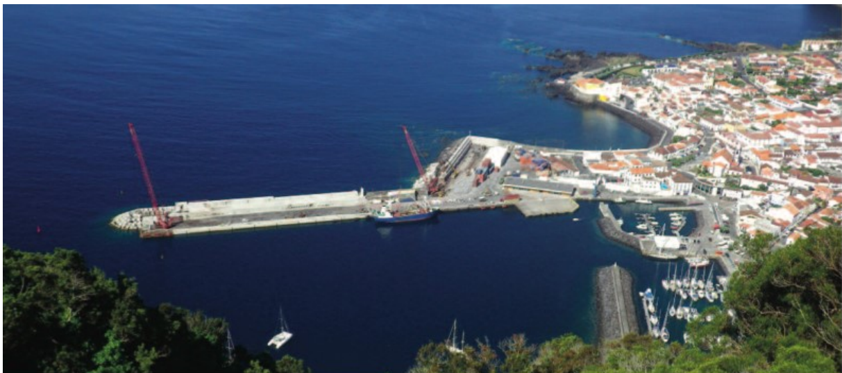
L'extension du brise-lames de Velas sur le point d'être achevée en juin 2018, les trois bouées mentionnées dans le texte étant clairement visibles. En octobre, elles ont été enlevées. Steve Ferrero
