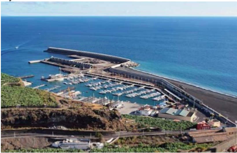
Puerto de Tzacorte en juin 2014. Les travaux du brise-lames extérieur sont presque terminés. Harald Sammer
